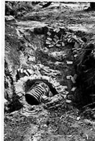
Los vándalos destruyeron obras hidráulicas que se hacen en la zona.
